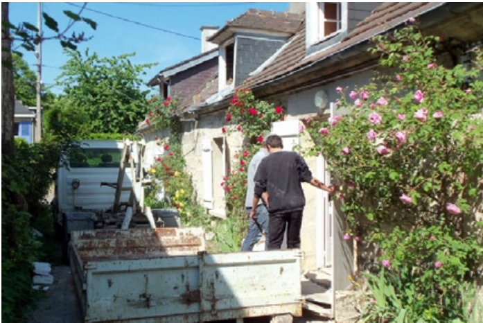
Obras de renovación en Rameau
